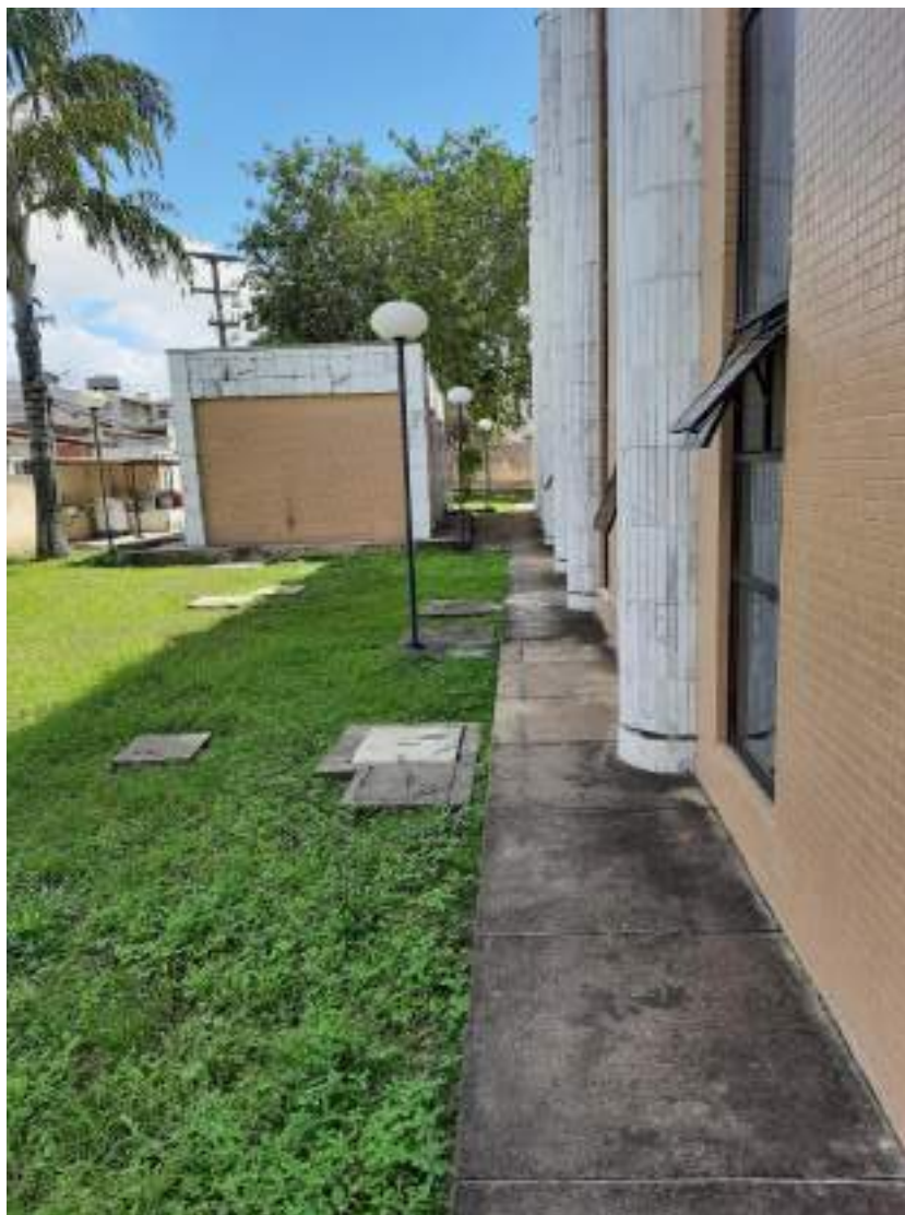
Foto 5.2.1.14 – Area Externa atrás do Edifício Anexo I.
