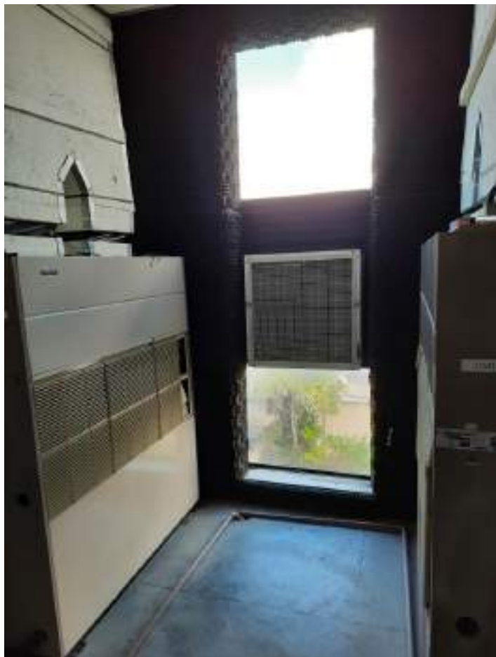
Foto 5.2.1.11 – Casa de Máquinas Edifício Anexo I.
