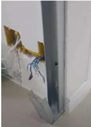
**Imagem 02:** Montante duplo fixado na guia inferior
