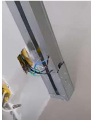
Guia inferior dobrada para reforço do batente, com montante encostado na alvenaria
