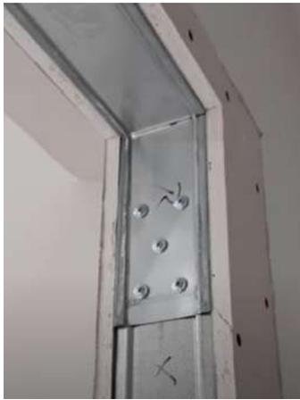
Reforço de cinco pontos, fixação com parafusos (bordas superior e inferior do drywall).
