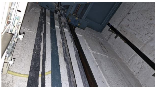
figura 12 - Cabos de comunicação dos elevadores
