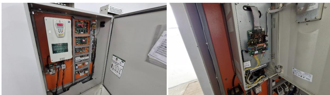
figura 7 – Inversor de frequência WEG
