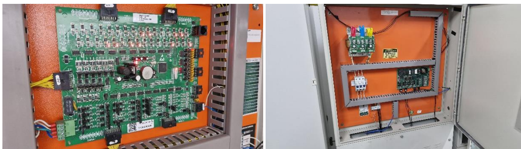
Figura 6 – Quadro elétrico e placa de comando
