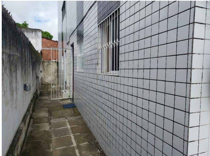
Acesso ao apartamento
