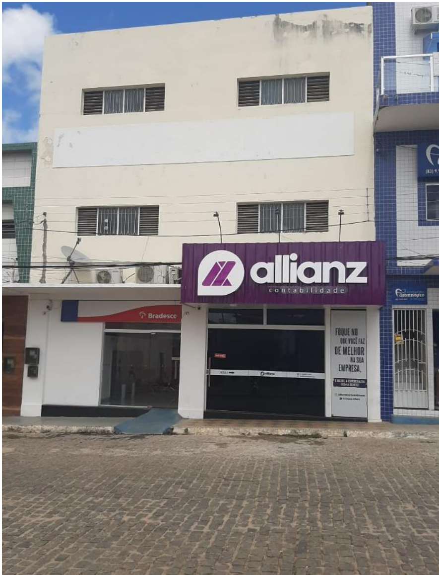
FACHADA DO PRÉDIO
