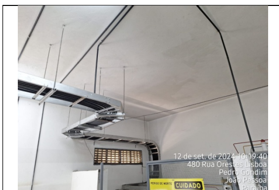
INSTALAÇÃO DE AR CONDICIONADO PARA CONTROLE DA TEMPERATURA
