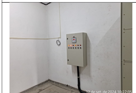
REVISÃO E MANUTENÇÃO DO BANCO CAPACITOR
