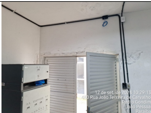
REALIZAÇÃO DE RENOVAÇÃO DA PINTURA
