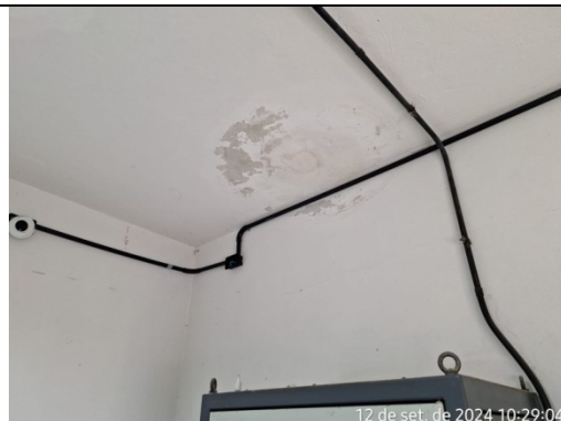
RENOVAÇÃO DA PINTURA E ACABAMENTOS
