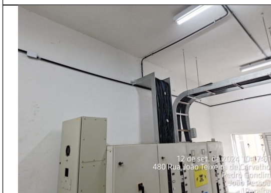
RECOLOCAÇÃO DA PLACA METÁLICA DE PROTEÇÃO DA FIAÇÃO
