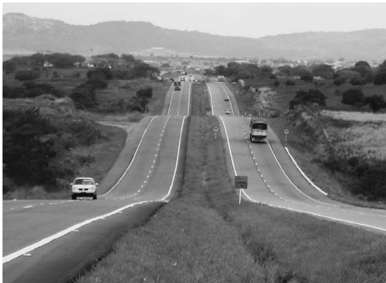
Rodovia transamazônica, trecho duplicado Campina Grande/Cabedelo.
