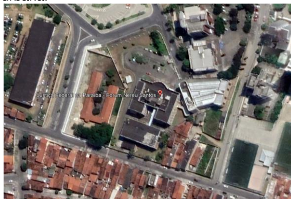
Figura 1 Imagem do local da instalação
